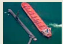
12. Puerto Guayacán (Terminal Graneles Sólidos)
