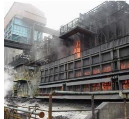
Planta de coque
