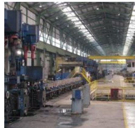
Dos laminadores de barras
